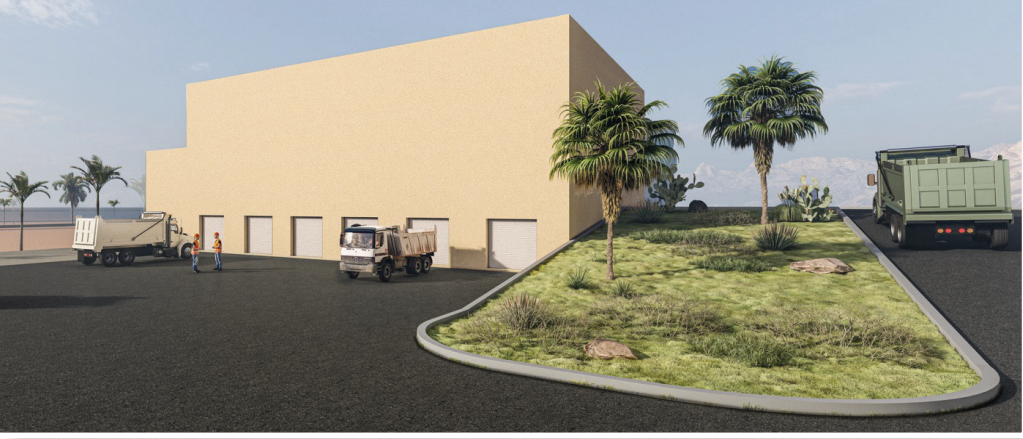
مبنى النفايات الصلبة
